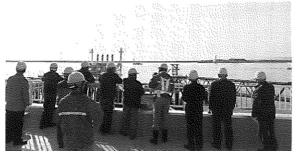
東北電力(株)新仙台火力発電所 LNG 栈橋建設現場視察
